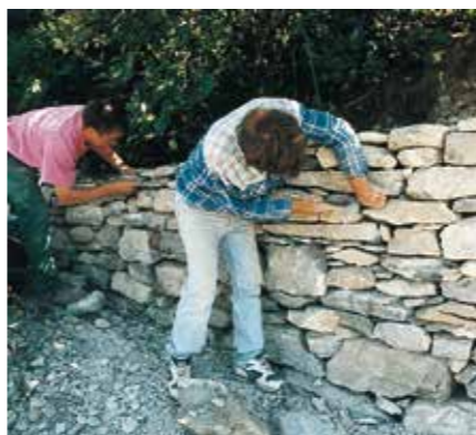
Reconstruction de murs
