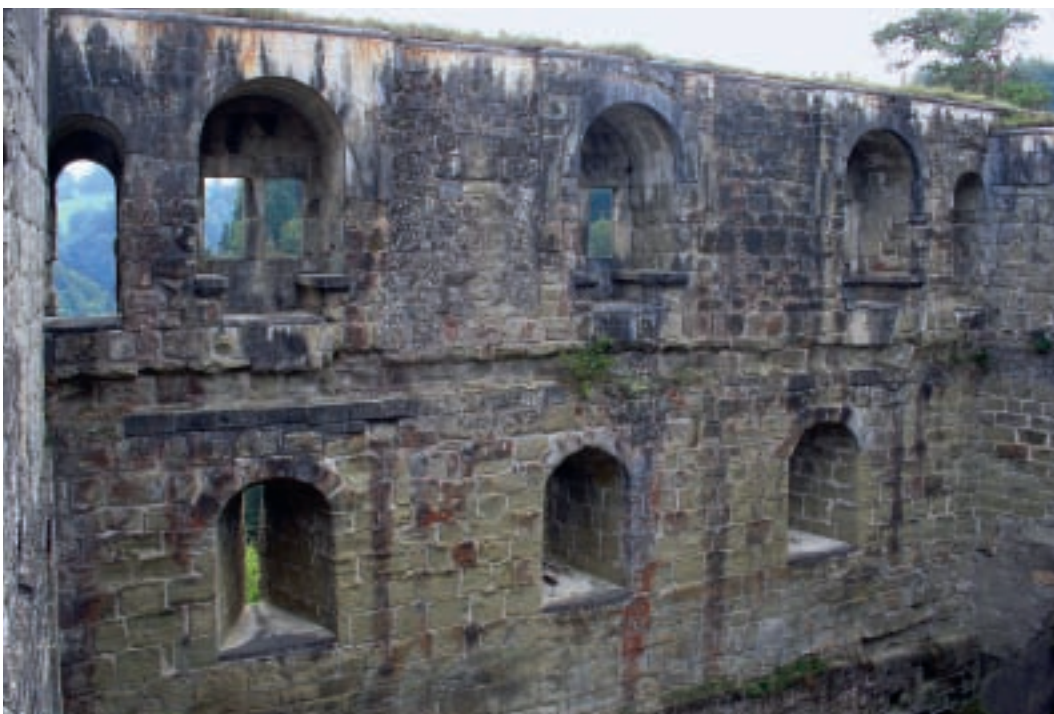
Abb. 9: Die Grasburg bei Wahlern. Die Südwand des Saales, Innenseite, 2009.
