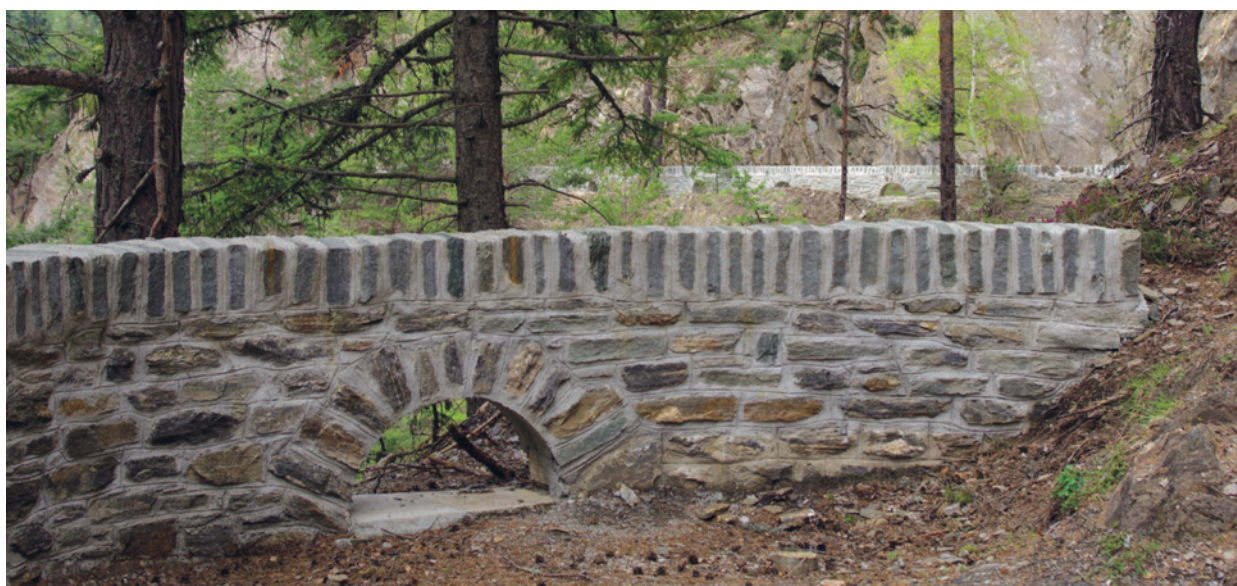
Abbildung 8. Von 2010 bis 2013 wurde die historische Strasse durch die Twingischlucht saniert.
