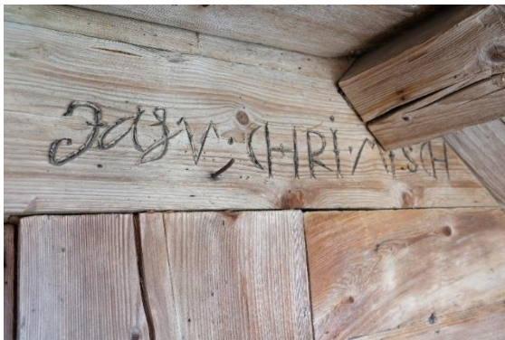
Speicher sind ein wichtiges Kulturgut
